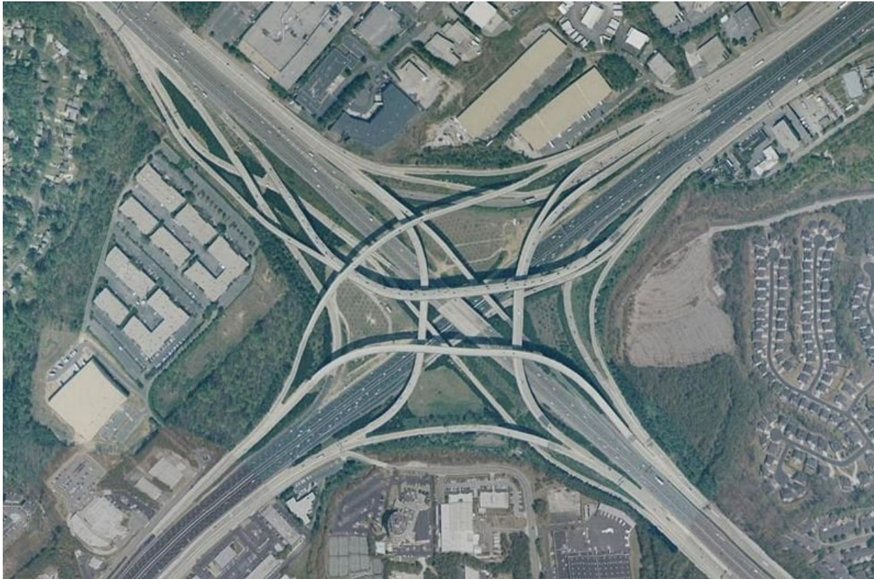
Intercambiador tipo spaghetti en Atlanta, Georgia, USA.
