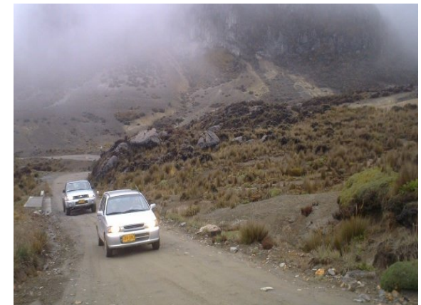
La infraestructura vial puede propiciar el desarrollo de una región al permitir el comercio de sus productos.
